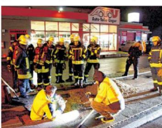
Explosiv: Der Stadtwerke-Bereitschaftsdienst schließt die Gas-Versorgung. Feuerwehr und Polizei sehen zu. FOTO: JENS REICHENBACH
